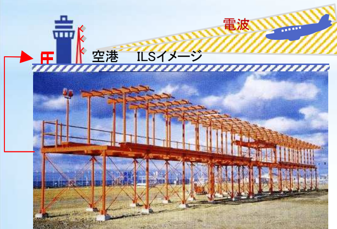
計器着陸装置として用いられるローライザ用アンテナ
