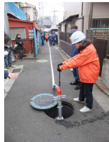
スタンドパイプから ホースの延長
