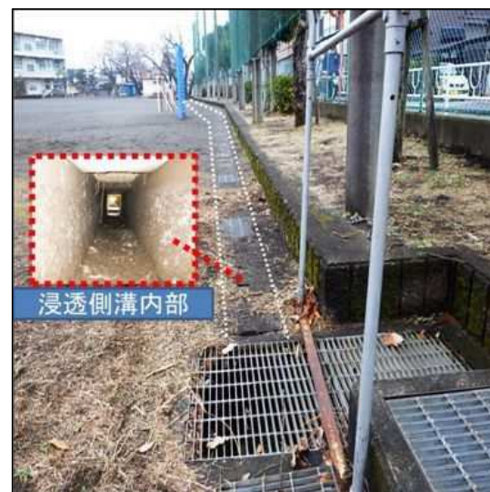
校庭貯留施設
