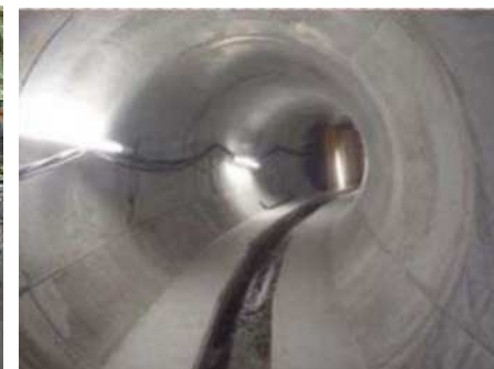
写真2 丸子その1雨水幹線（管内）
