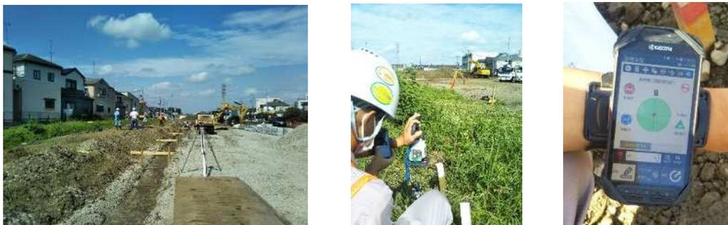
図 小規模現場における試行状況 (ICT測機による省力化)
