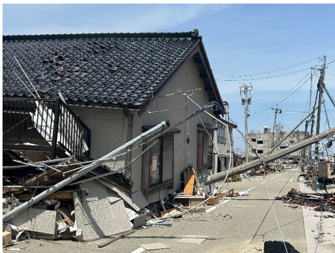
令和6年能登半島地震(珠洲市)
